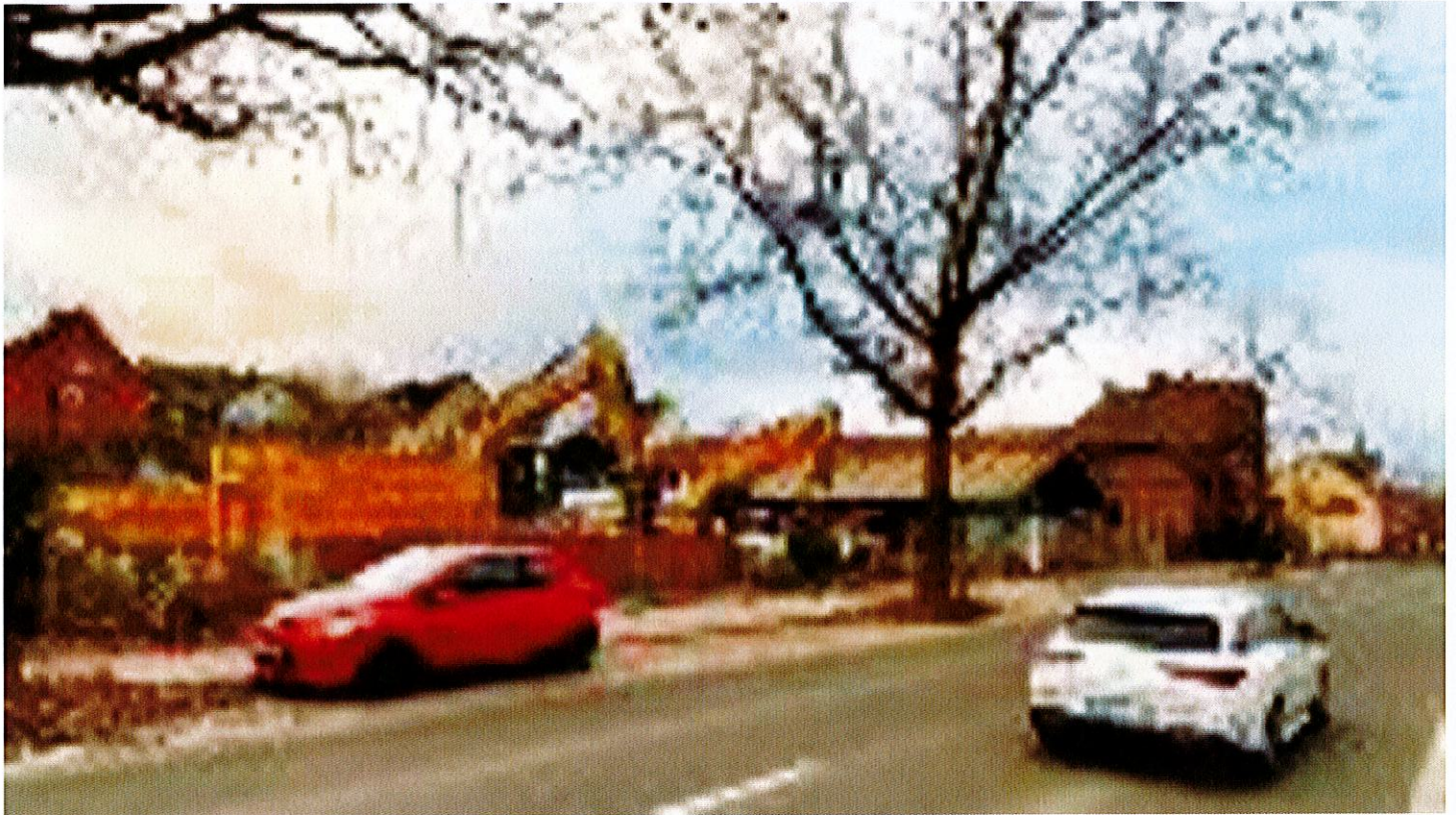
Die Abrissarbeiten der ehemaligen Gärtnerei am Harztor in Northeim sind fast beendet. Hier entsteht das neue Heim. © Axel Gödecke
